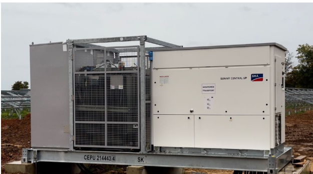
SMA Zentralwechselrichter 5 MW
